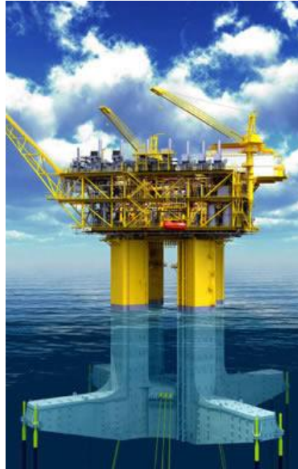
Figura 4 Plataforma con Piernas Tensionadas, RigZone.
