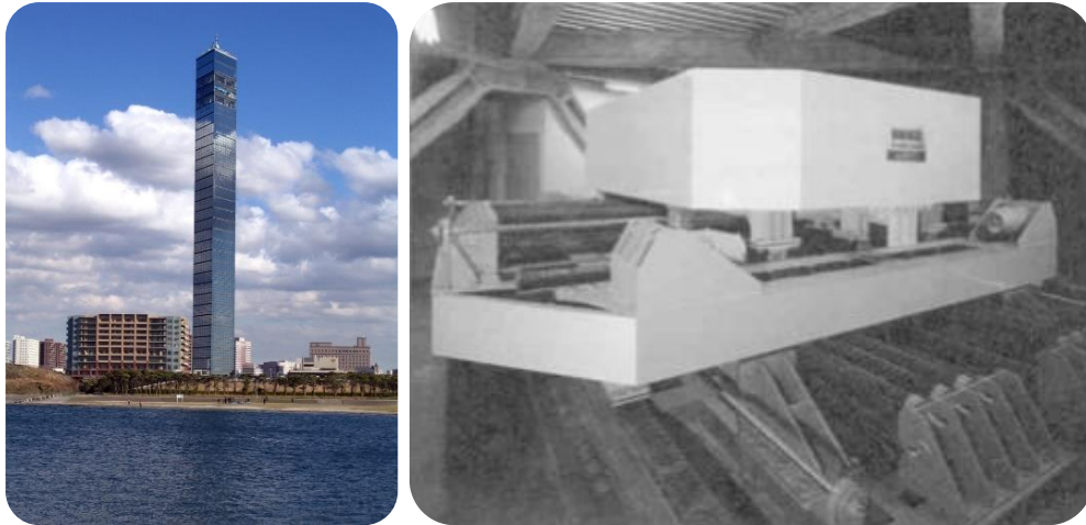
Figura 10. Rascacielos Chiba-Port y su dispositivo disipador MSS. Connor, 2002 y https://goo.gl/67ympV .
