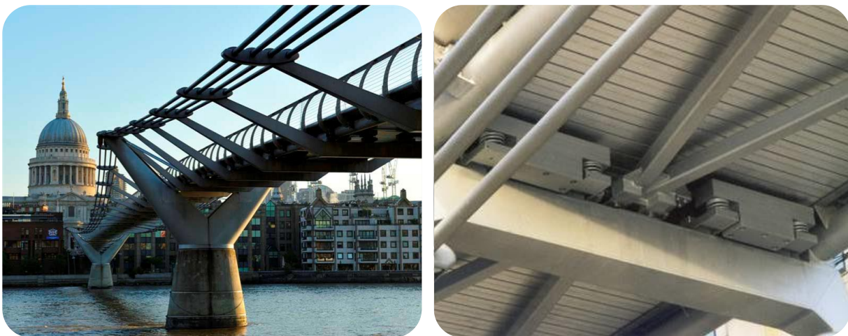
Figura 11. Puente Milenio y sus dispositivos disipadores MSS. https://goo.gl/ybe48A y https://goo.gl/x2ZJwB .
