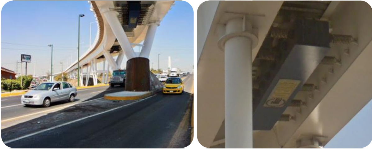
Figura 14. Puente Álamo sus dispositivos disipadores MSS. Datos del mapa ©2017 Google, INEGI https://goo.gl/FQCHSj y https://goo.gl/XexmHY .
