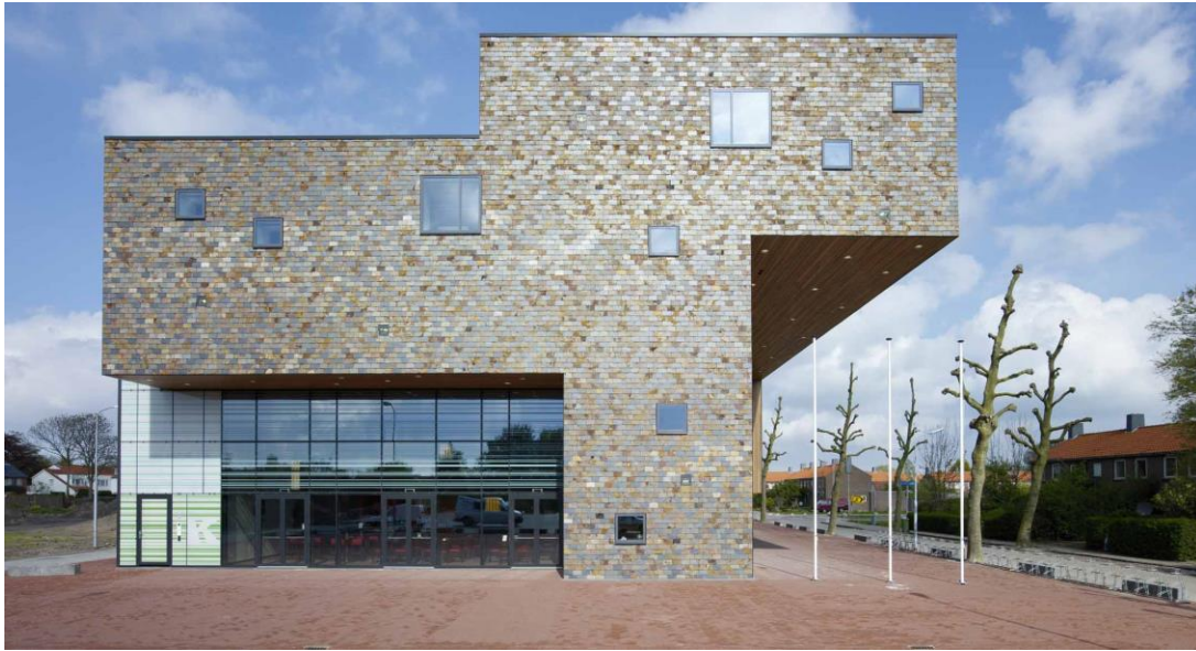
Gráfico 37. Fachada Norponiente del Centro de Artes y Teatro Pier K
