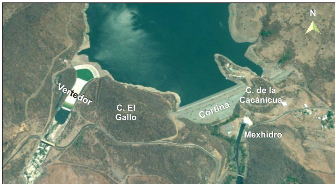
Figura 2. Imagen tomada de Google Earth Pro, se muestra la cortina de la Presa “El Gallo”, el vertedor, cerros El Gallo y Cacánicua e instalaciones de Mexhidro.
