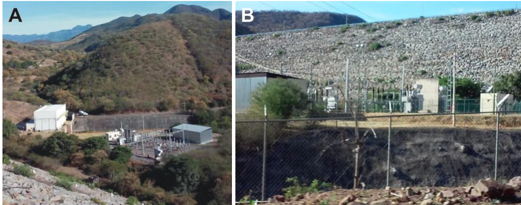
Fotografías 24. A. Vista de las instalaciones de Mexhidro desde la parte alta de la cortina de la presa. B. Vista frontal de la cortina de la presa desde las instalaciones de Mexhidro. (Fotografías tomadas por la autora en 2016).
