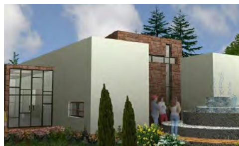
Vista exterior del Templo.
