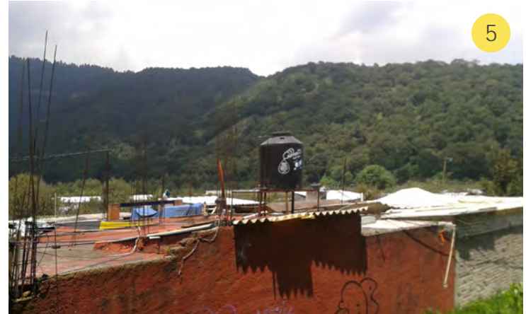
Arellano, P. 2015. Viviendas precarias (autoconstrucción) abandonadas de 1 nivel.
