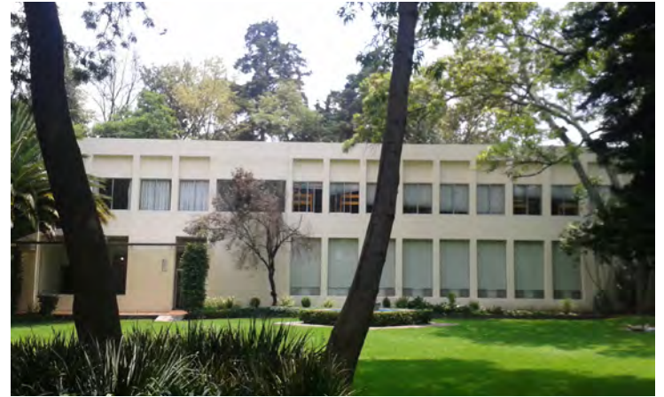
Arellano, P. 2015. Fachada poniente (Aulas y dormitorios). No cuenta con elementos para contrarrestar los rayos del sol.
