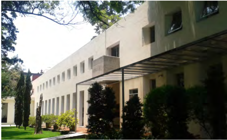
Arellano, P. 2015. Fachada Norte (Aulas y administración). Existe proporción y escala entre los vanos y los macizos.
