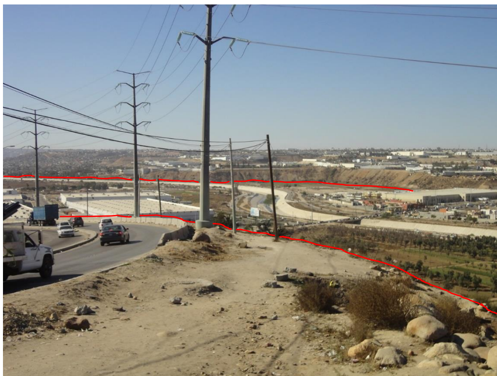
Figura III.4 Fotografía del margen izquierdo del arroyo Alamar; las líneas rojas muestran el límite aproximado de la planicie aluvial y entre éstas se observa la canalización de concreto.
