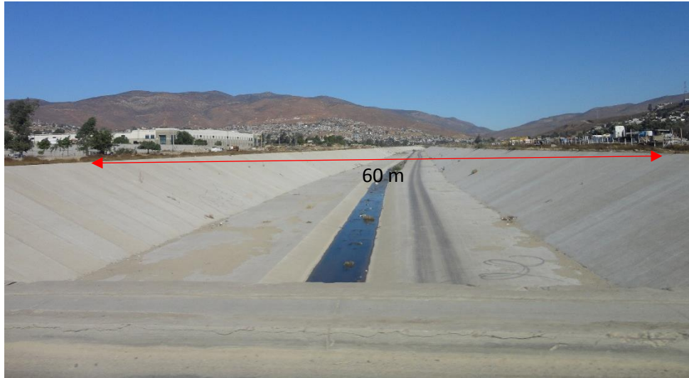
Figura III.5 Fotografía con vista al este de la canalización del arroyo Alamar.
