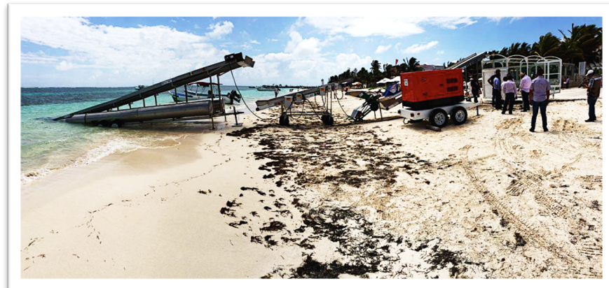
Figura 1.6 Banda transportadora en Puerto Morelos
