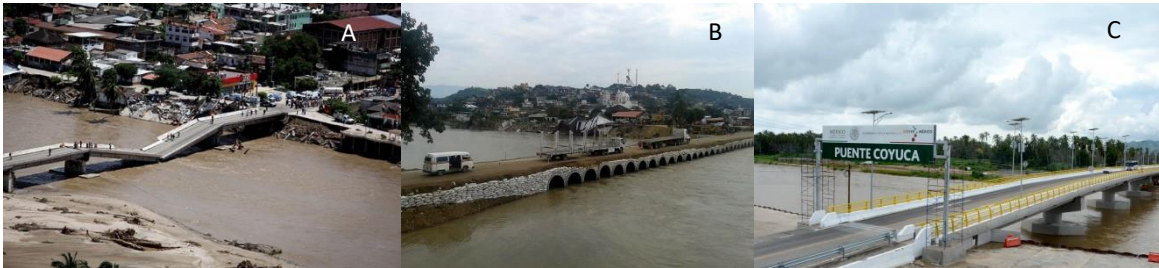
Figura 8. Puente Coyuca en el Estado de Guerrero. A) Colapso del puente. B) Puente provisional construido 15 días después del colapso. C) Nuevo puente Coyuca construido un año y dos meses después. Fuente: www.eluniversal.com.mx
