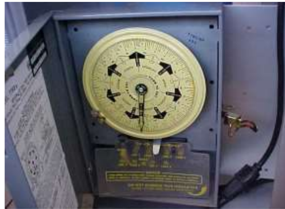
Figura 2.9A: Interruptor manual (Temporizador).
