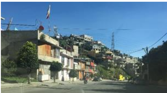
Imagen 13 Vivienda de autoconstrucción en zonas de la periferia Fuente: tomada por el autor 2015
