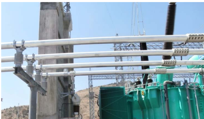
Imagen 5. Tubo de aluminio de 6" cédula 80 empleado para buses rígidos del devanado terciario.
