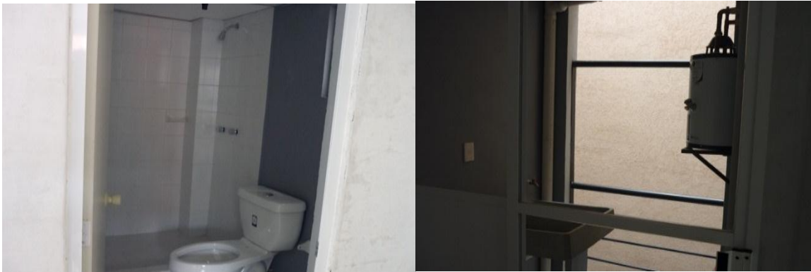
Fotografía 28 y 29. Predio ubicado en Gitana No. 172, Delegación Tláhuac. (Con 133 acciones de vivienda) Antes de ser entregadas las viviendas a los beneficiarios, se revisa que efectivamente cuenten con los dispositivos sustentables.
