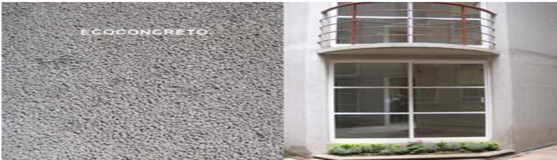
Fotografía 27. Ejemplo de uso de ecoconcreto en el edificio INVI "DR. ATL"; este material sustentable se utiliza principalmente en el área de estacionamiento y en áreas comunes de algunos edificios.
