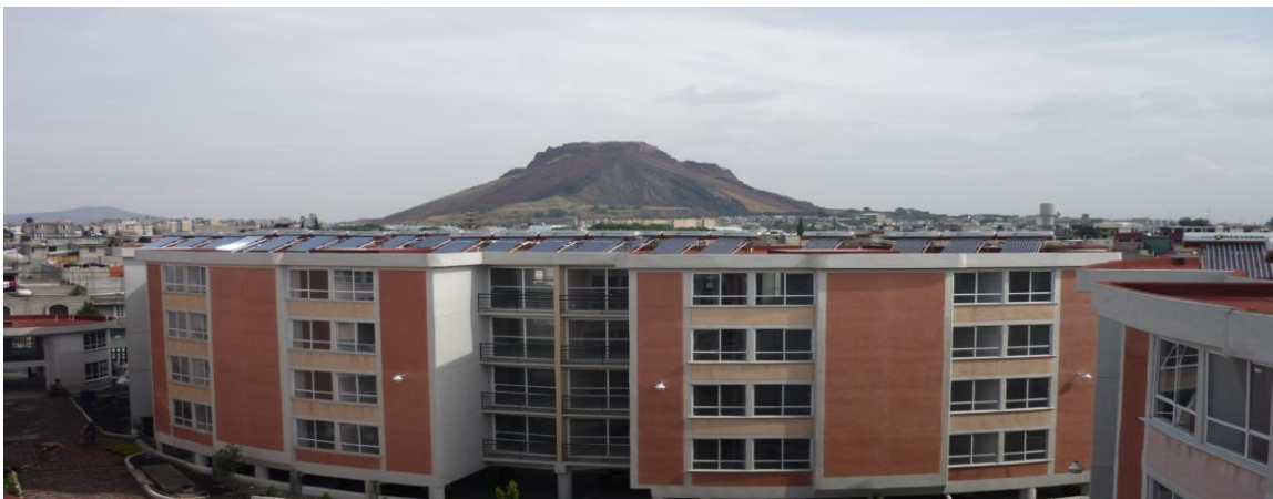
Fotografía 30. Predio ubicado en Gitana No. 172, Delegación Tláhuac. (Con 133 acciones de vivienda) Antes de ser entregadas las viviendas a los beneficiarios, se revisa que efectivamente cuenten con los dispositivos sustentables.
