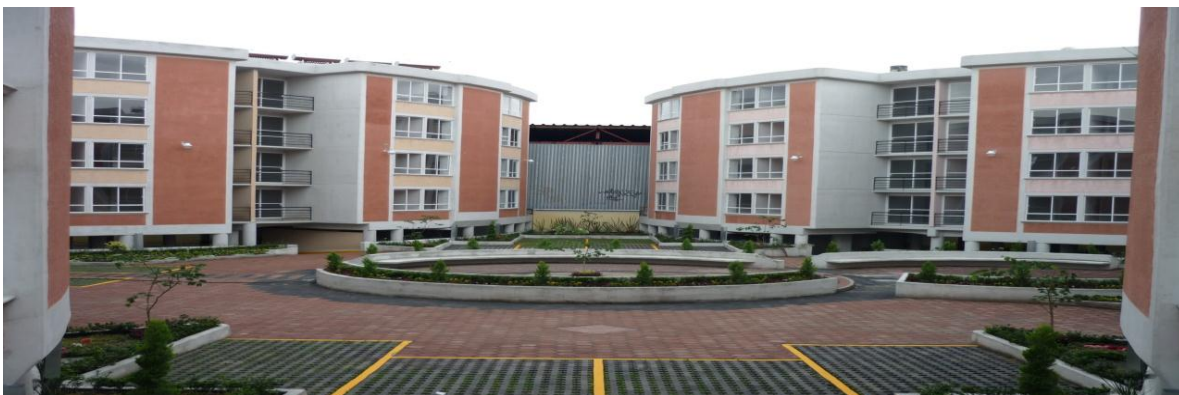
Fotografía 31. Predio ubicado en Gitana No. 172, Delegación Tláhuac. (Con 133 acciones de vivienda) Antes de ser entregadas las viviendas a los beneficiarios, se revisa que efectivamente cuenten con los dispositivos sustentables.
