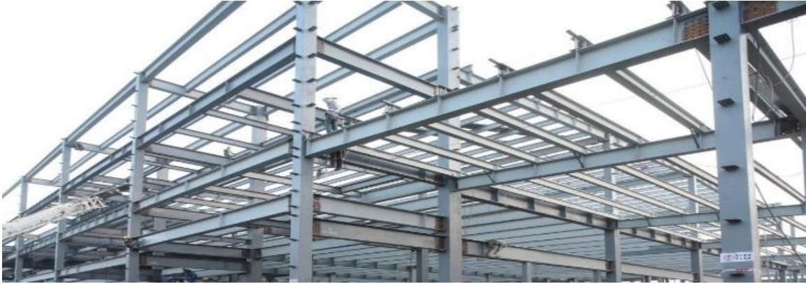
Fotografía 18. Estructura metálica de un edificio en Reino Unido.
