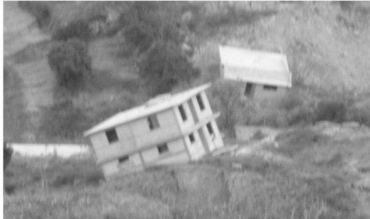
**IMAGEN I.7. Estructura dañada por volteo esto debido al Movimiento de tierra**
