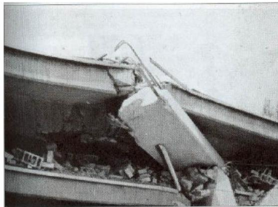
**IMAGEN I.3. Escases de anclaje viga-columna**
