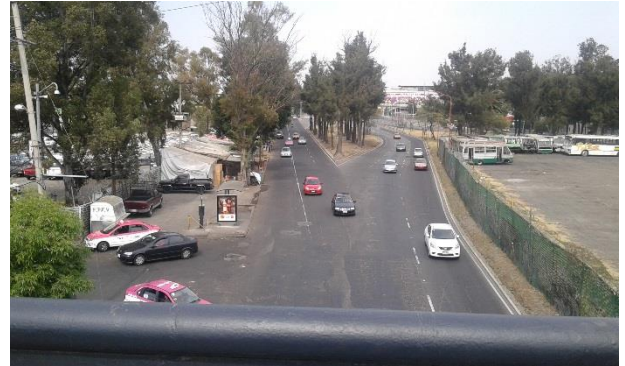
Fig.2.13 Fotografía de Av. Canal de Garay, en la sección del área de estudio.
