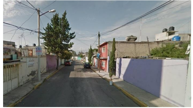
Fig.2.11 Fotografía de la calle Nueva Evolución, donde se muestra su estado actual.
