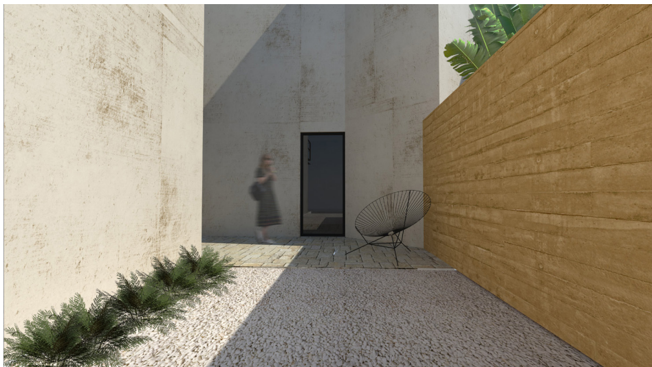
Patio casa tipo 2
