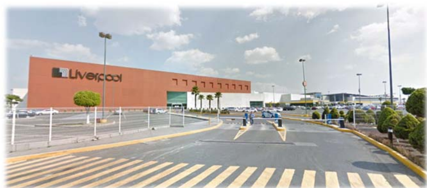
Centro Comercial Las Américas en Fraccionamiento Las Américas, Fotografía de Archivo Personal
