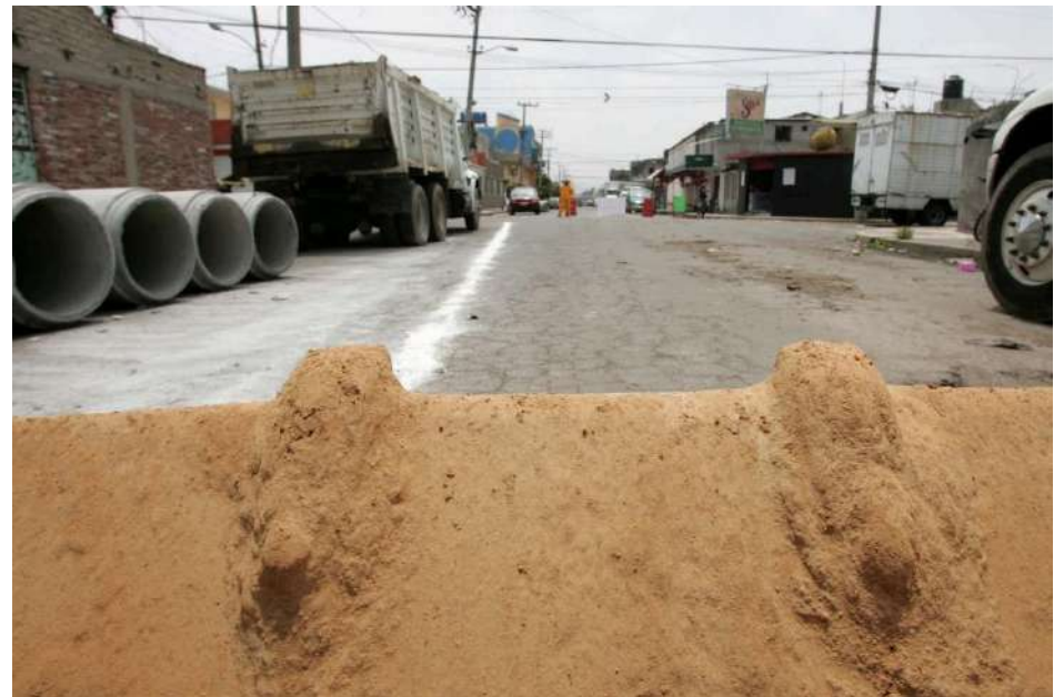
Ilustración 28 Rehabilitación de red de drenaje en colonias de Nezahualcóyotl Fuente: https://reporterosenmovimiento.files.wordpress.com/2013/11/jg2g8606.jpg
