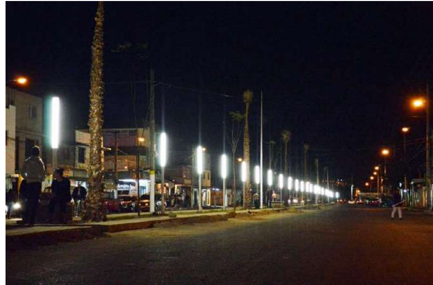
Ilustración 41 Cambio de luminarias en Av. principales del Municipio Fuente: https://feyiyi1.files.wordpress.com/2014/07/dsc_1200.jpg
