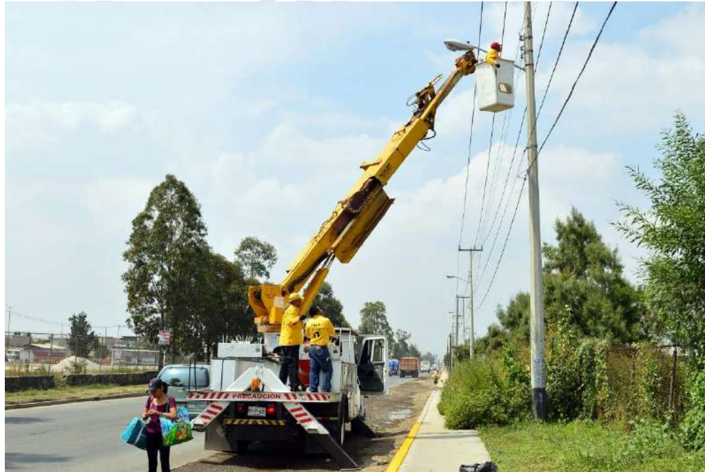
Ilustración 29 Instalación de luminarias en el Municipio de Nezahualcóyotl Fuente: https://reporterosenmovimiento.files.wordpress.com/2013/10/dsc_8112.jpg
