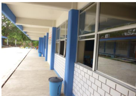
Figura 3. Aulas del plantel COBACH No. 27.
