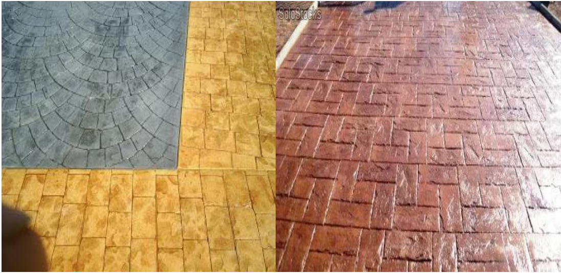
FIGURA 67. Pavimento de concreto texturado.
