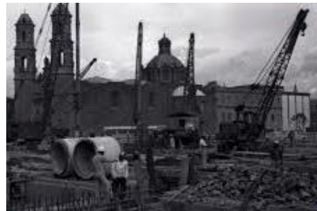
Ilustración 13. Construcción del metro
