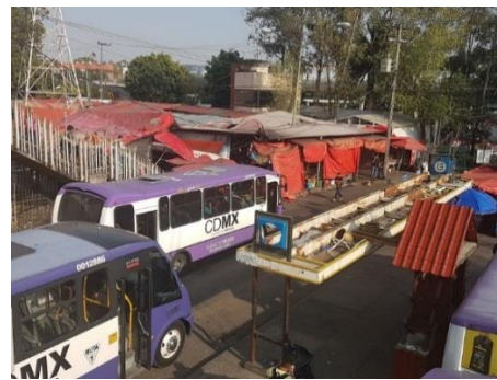
Fotografía 4. Exceso de comercio ambulante y mal estado de la infraestructura actual
