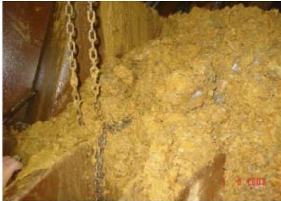
Figura 2.7 Colapso por inestabilidad en el terreno. (Zhao et al., 2007)
