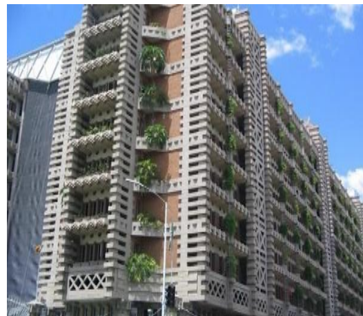
Ilustración 32 Refrigeración en el centro Eastgate
