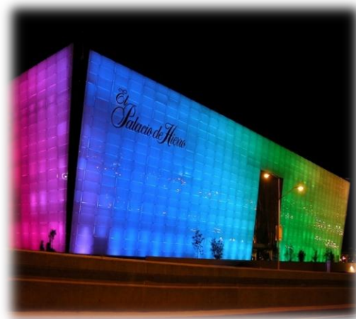
Ilustración 4 Palacio de Hierro Monterrey
