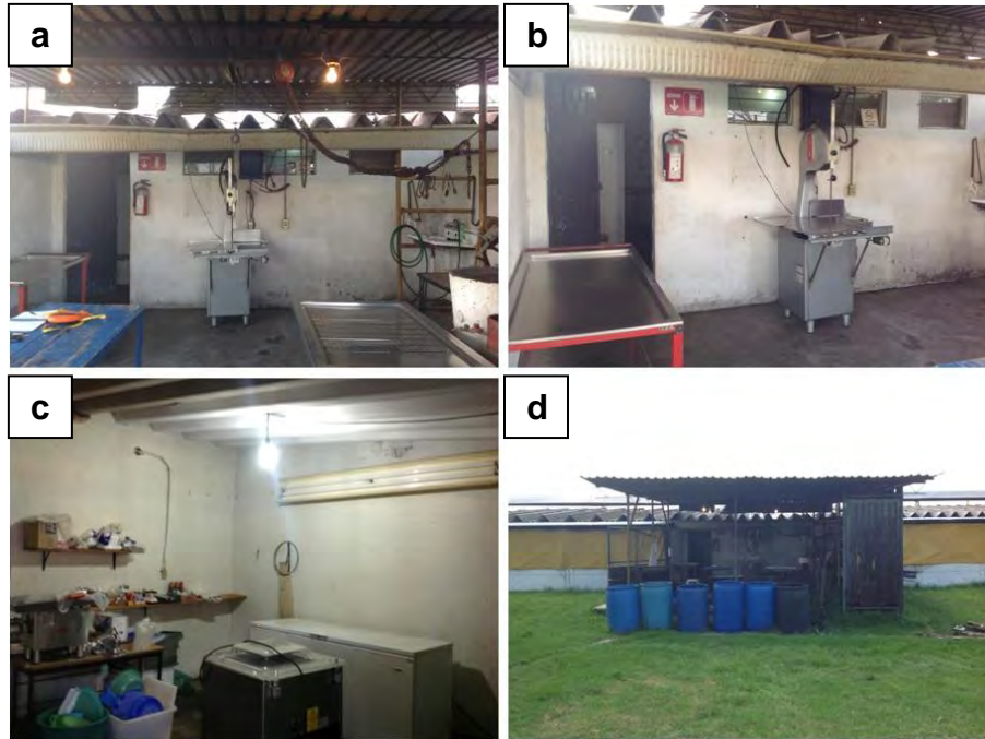
Figura 1. Instalaciones actuales en donde se propone la construcción de quirófano en el CEIEPP, Edo. Mex. 2016. a) Área externa de la instalación. b) Muro de separación entre la parte externa de la instalación. c) Área interna de la instalación. d) Área verde aledaña a la instalación. (Robles JA, 2016)
