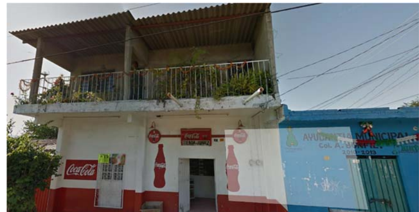
Imagen 4: Casa habitación con uso comercial en planta baja, edificación de autoconstrucción y techo de lamina.
