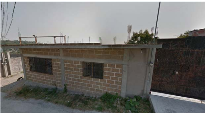
Imagen 10: Casa habitación de 1 nivel, de autoconstrucción, con material de acabado aparente. 99
