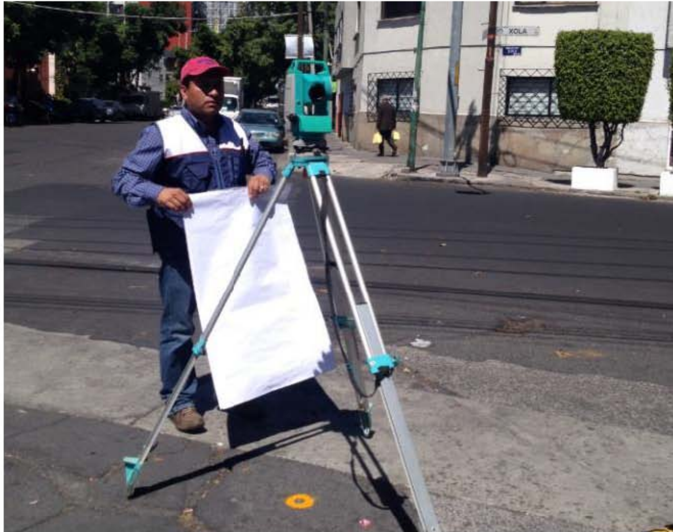
Colocación de puntos auxiliares para el levantamiento y trazo del límite de predio.
