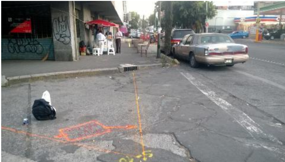
Se delimito con marca de pintura el límite de predio
