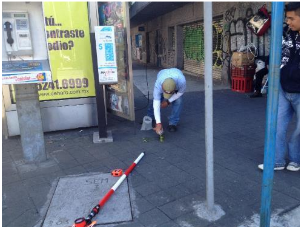
Colocación de clavos para delimitar la zona
