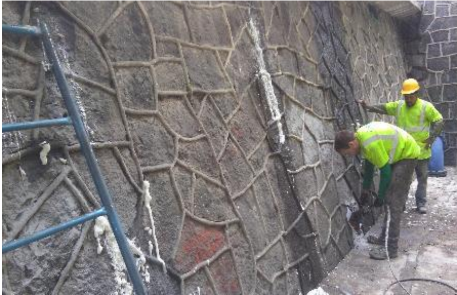
MANTENIMIENTO A TANQUE DE AGUA SACMEX, IZTAPALAPA
