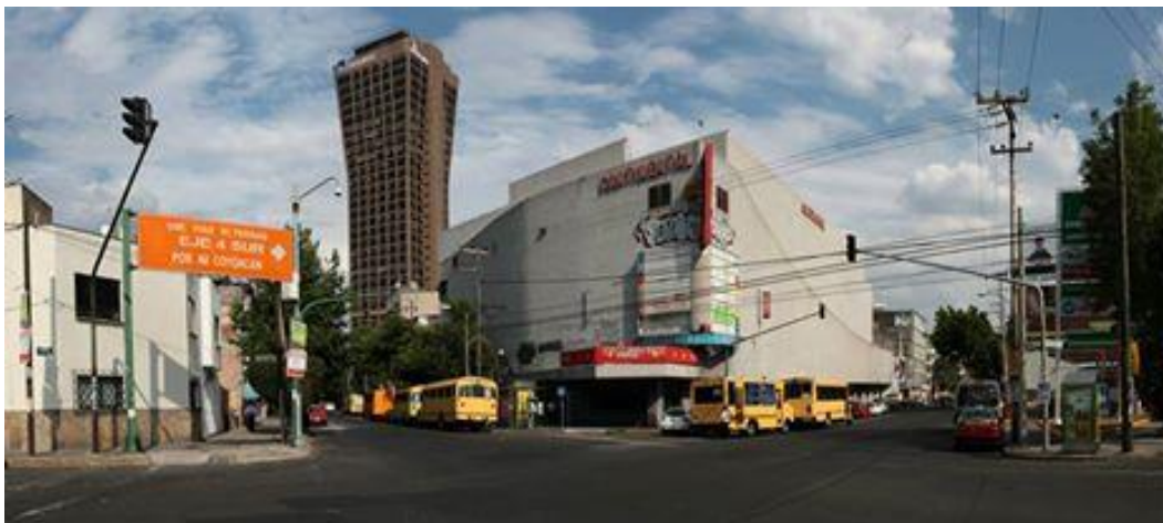
CINE CONTINENTAL PREVIO AL PROCESO DE DEMOLICIÓN
