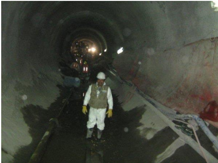
MANTENIMIENTO AL DRENAJE PROFUNDO CIUDAD DE MÉXICO
