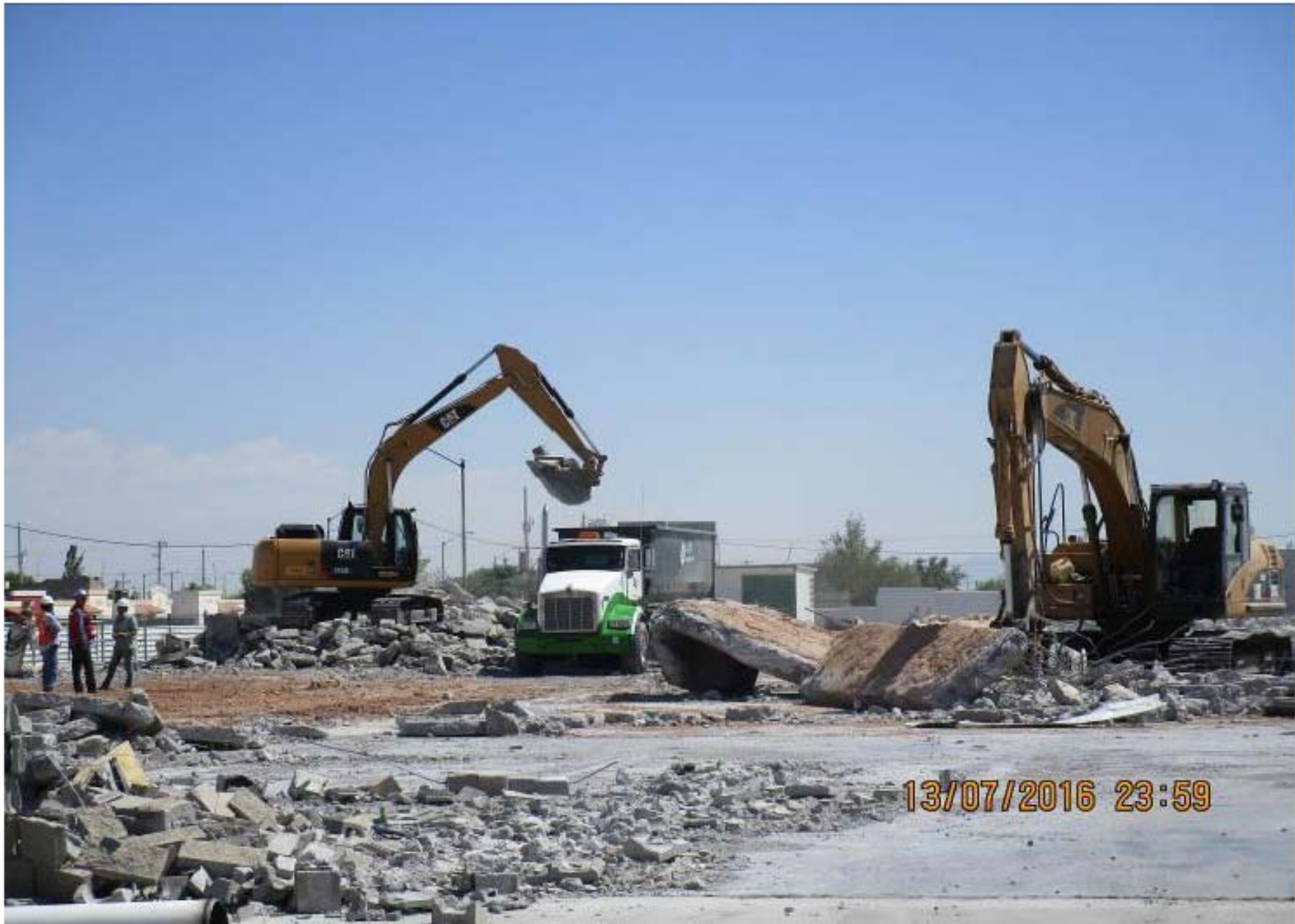
DEMOLICIÓN POR MEDIOS MECÁNICOS
