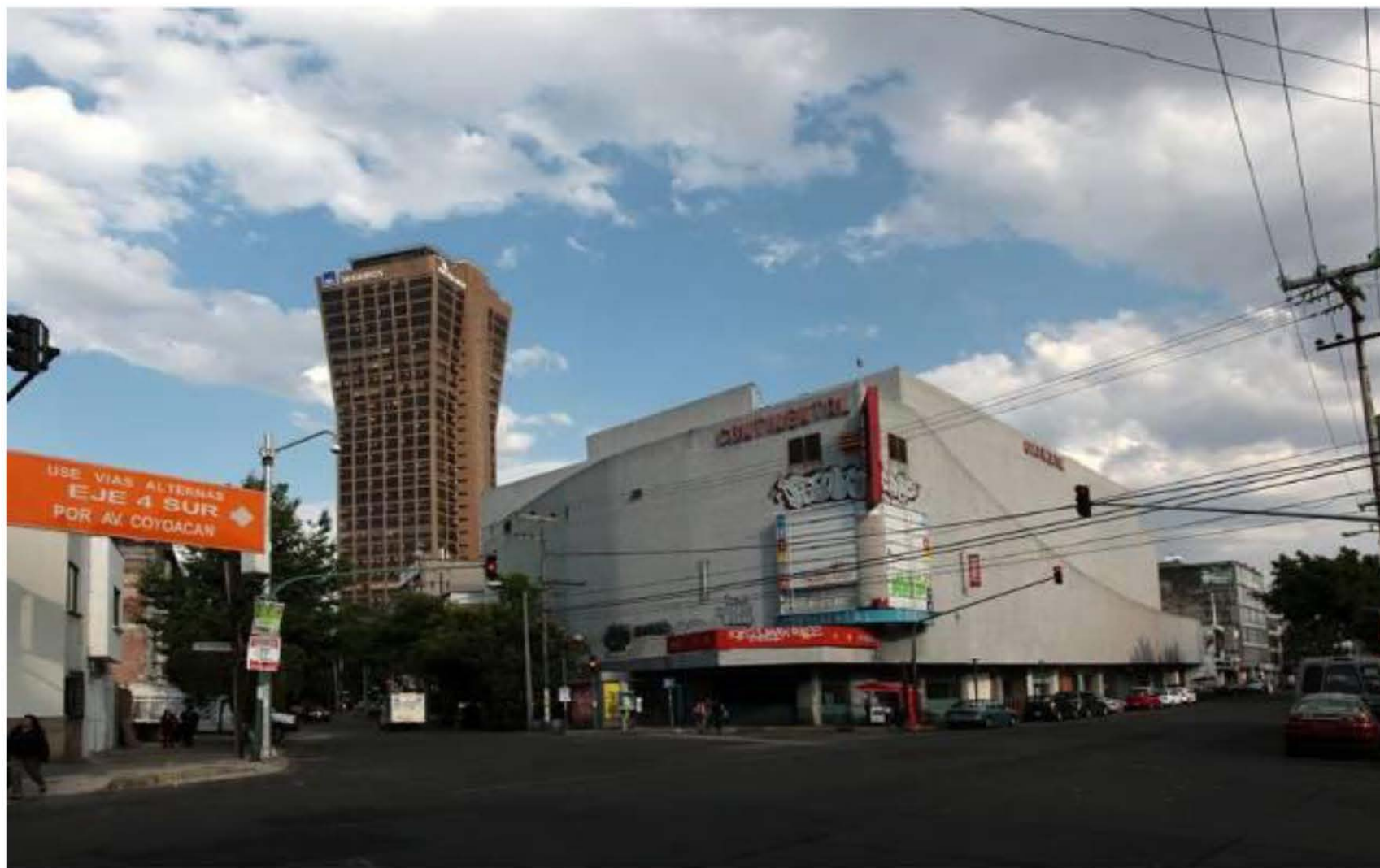
FOTOGRAFÍA EN PERSPECTIVA EXTERIOR DEL EX CINE CONTINENTAL PREVIA A SU DEMOLICIÓN
