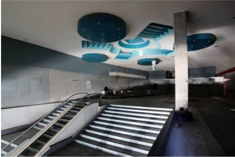
(INTERIOR ANTES DE LA DEMOLICIÓN)
