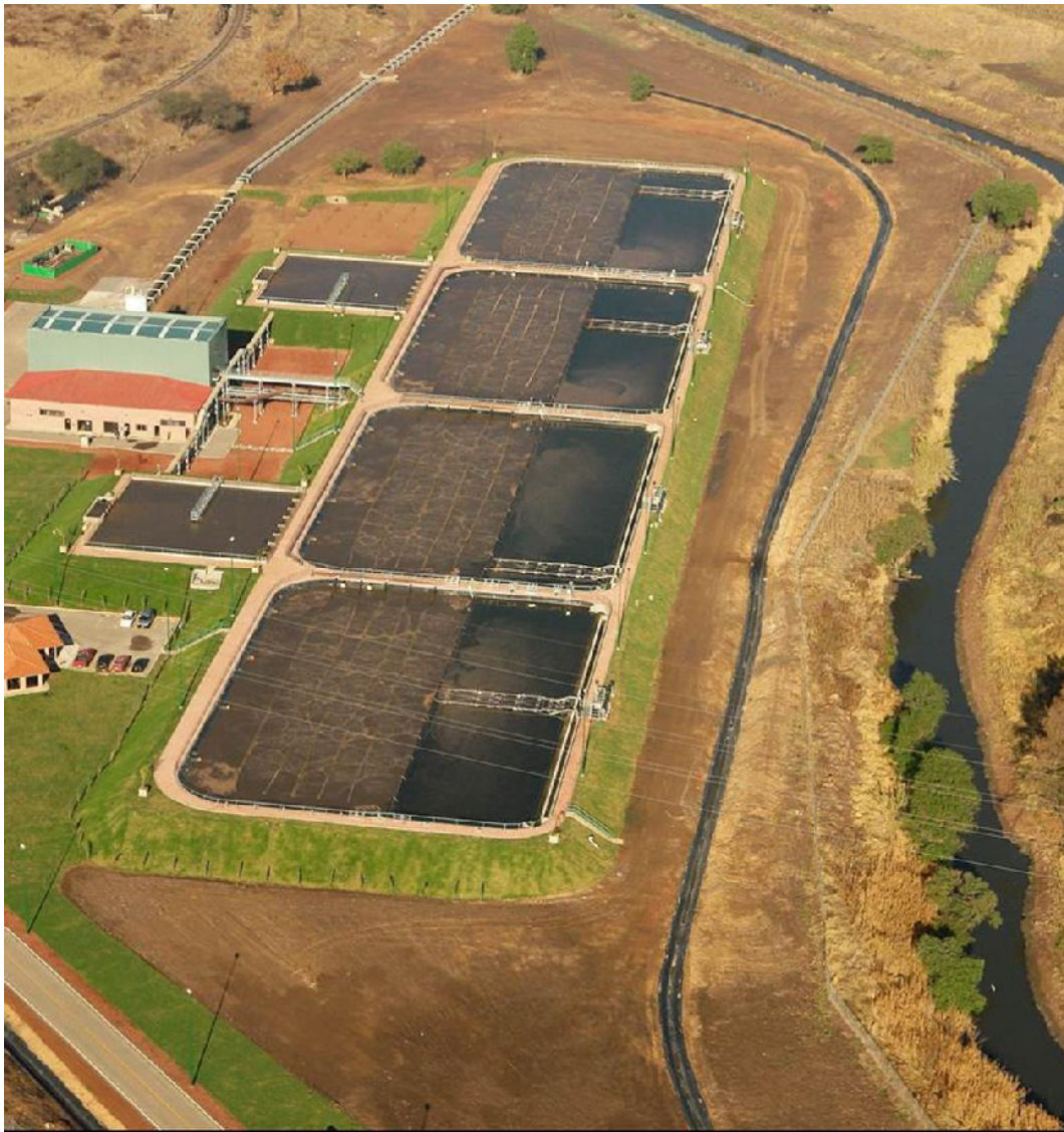
PTAR Atapaneo, ubicada en la Ciudad de Morelia, en el estado de Michoacán, México
