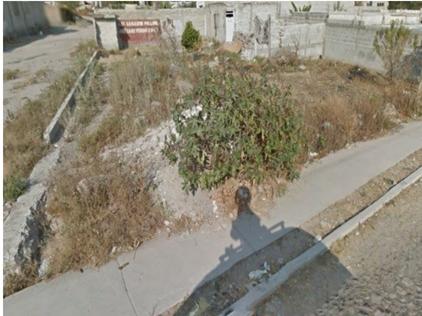
Fotografía 4.- Calle 26 de Enero, terreno baldío con obra negra incompleta, cerca de terminal de autobús.
