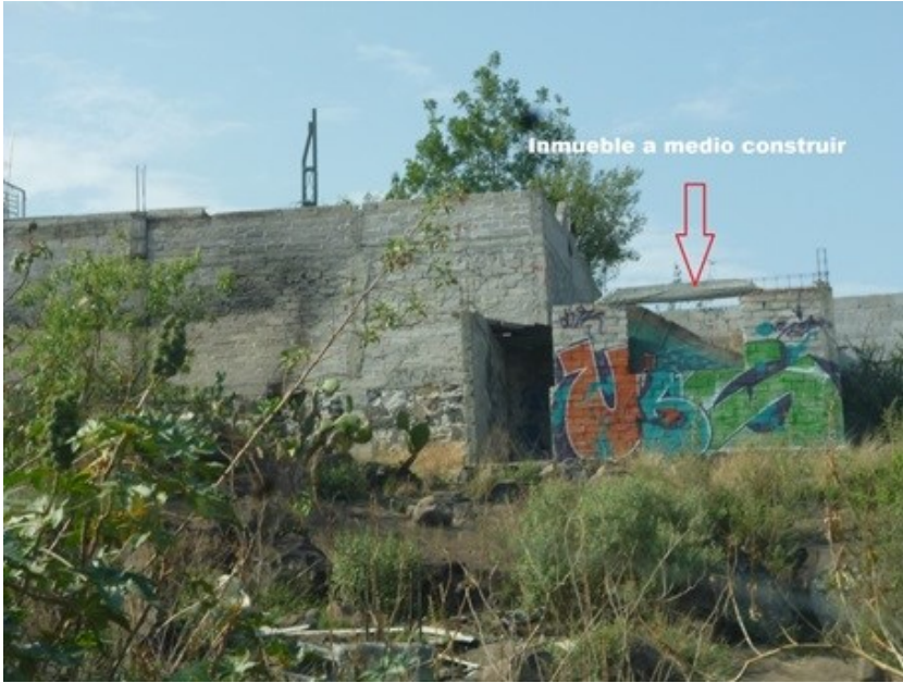
Fotografía 3.- Calle Cerro Colorado, inmueble en obra negra a medio construir.
