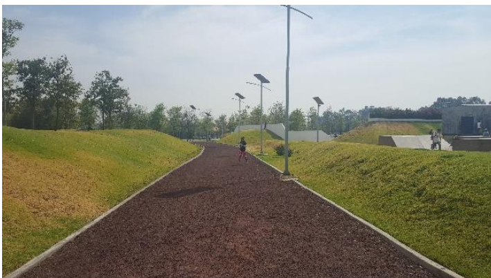
Imagen 36. La trotapista ofrece agradables senderos para caminar o trotar con áreas verdes a los alrededores, el pavimento que la compone es de tepetate comprimido y cuenta con un sistema de luminarias de tipo solar. Autoría propia [2016].
