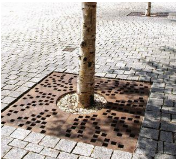
Imagen 44. Rejilla para cajete, sirve para que la filtración sea de forma natural, además permite que la raíz del árbol tenga espacio suficiente para crecer, lo que evita fracturas en el pavimento. Por Velopa, http://www.velopa.com/productcatalog/street-furniture/cortengo/
