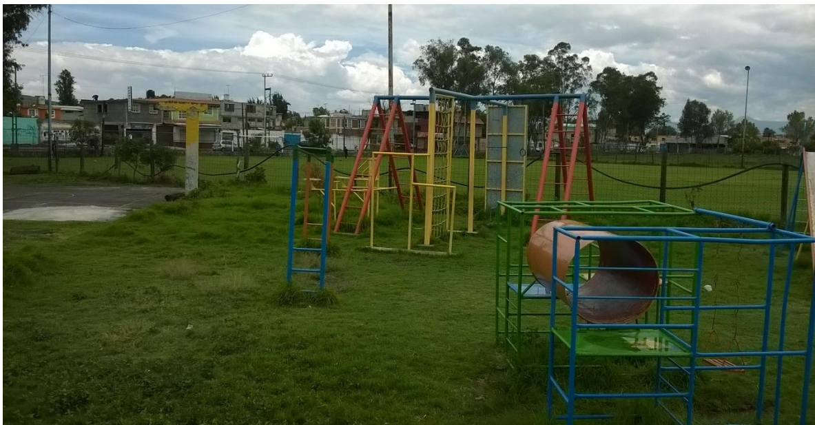
Imagen 7. Deportivo el Triángulo. Área Infantil no definida, en la cual los juegos únicamente están anclados al terreno, no cuenta con pavimento de bajo impacto para uso infantil, como pueden ser baldosas de caucho y no existe el mobiliario urbano que requieren este tipo de áreas, como son bancas, luminarias, etc. Autoría propia [2016].
