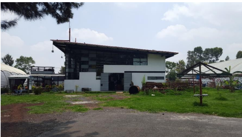
Imagen 23. Fachada Sur (Salida de emergencia). Aprovechamiento de la luz natural, a través de un vitral modulado y una doble altura.
