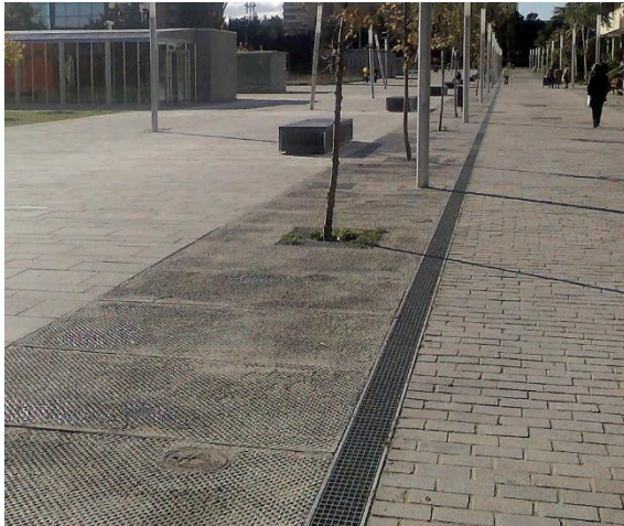
Imagen 42. Dren con rejilla para la recolección de aguas pluviales, es registrable en cualquier punto y fácil de limpiar. Por COSAS DE ARQUITECTOS, http://www.cosasdearquitectos.com/2014/06/conoces-el-canal-de-drenaje-oculto/
