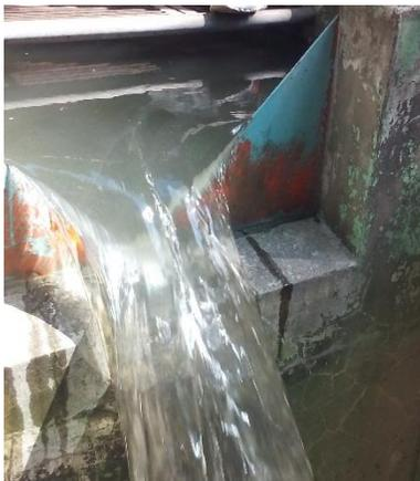
*Vertedor triangular ubicado en la salida del cárcamo principal.*
