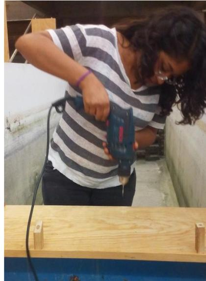
*Instalación de los sujetadores de base para el vertedor de laberinto.*
