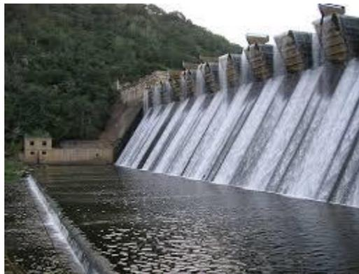
***Ilustración II. 15 fotografía vertedor tecla de piano.***
