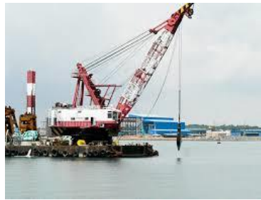
Ilustración 4-7, pílón instalado en grúa (Marine, 2015).
