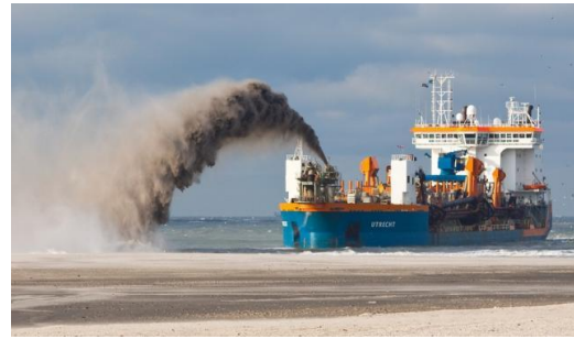
Ilustración 4-4, Descarga por bombas, ©2007- 2017 The Construction Index.
