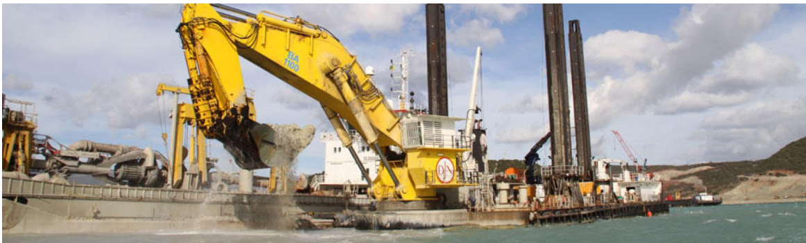
Ilustración 5-6, Draga tipo dripper de retroexcavadora (Promares, 2015).
