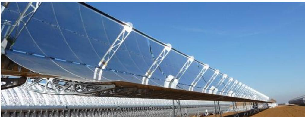
**Figura 1.12 Colector Cilindro Parabólico en San José del Valle, Cádiz, España
