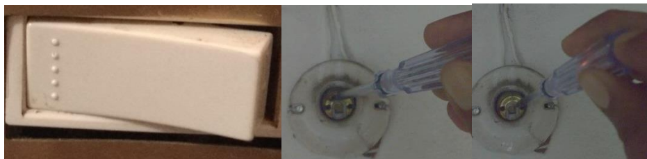
Imagen 132. Terminales del portalámparas conectado correctamente.
