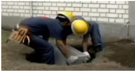
Imagen 107. Colocación de registro prefabricado.
