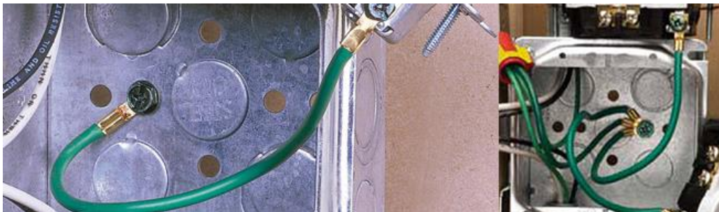
Imagen 71. Conexión de la caja metálica al conductor de puesta a tierra (Fuente: http://www.idealind.com/US/EN/Products/Wire-Termination/ )
