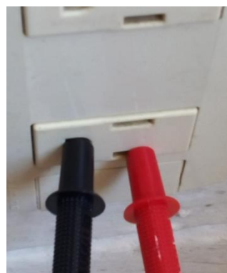
Imagen 122. Prueba de falla a tierra en contacto.
