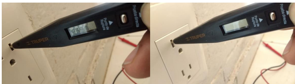
Imagen 127. Verificación del funcionamiento del probador digital; izquierda: fase; derecha: neutro.
