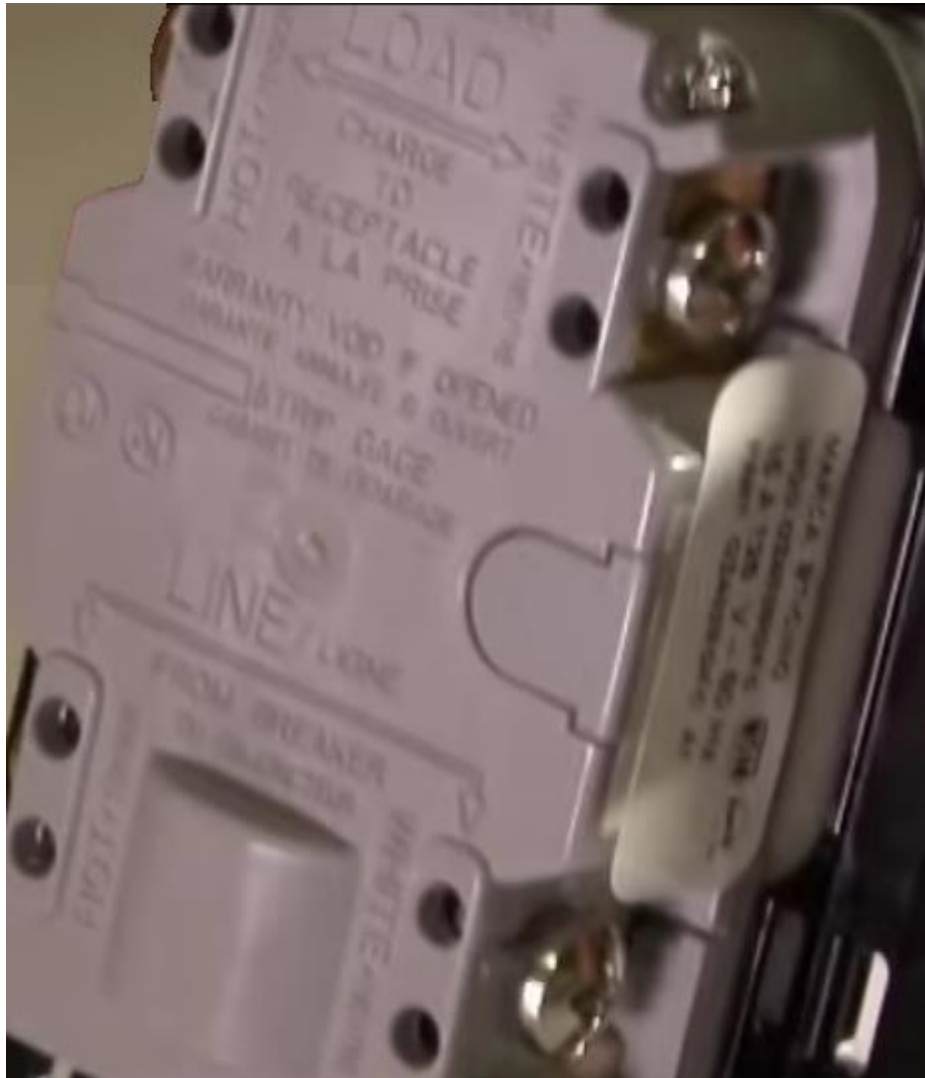
Imagen 53. Vista posterior de un contacto doble con protección de falla a tierra.
