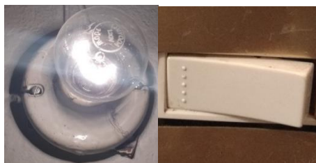
Imagen 129. Prueba de alimentación del foco.
