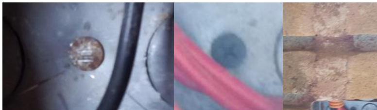
Imagen 76. Fijación de caja a muro de ladrillo
