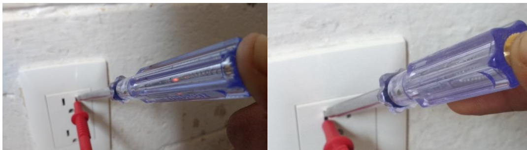
Imagen 128. Verificación del funcionamiento del probador analógico. Izquierda: fase; derecha: neutro.
