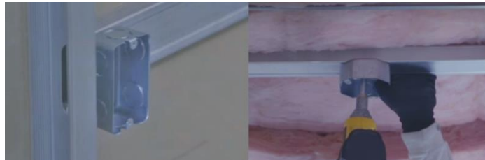
Imagen 77. Fijación de cajas. Se atornillan sobre refuerzos de canal metálico, previamente fijados a los postes o listones (Fuente: Panel Rey)
