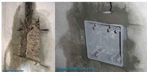
Imagen 74. Colocación de caja plástica en tabique (Fuente: sugarmtnfarm.com )
