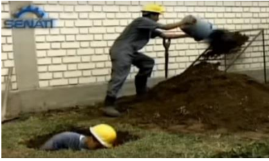
Imagen 105. Excavación del pozo y tamizado de la tierra.
