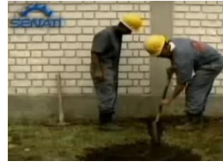
Imagen 106. Excavación de la zanja.
