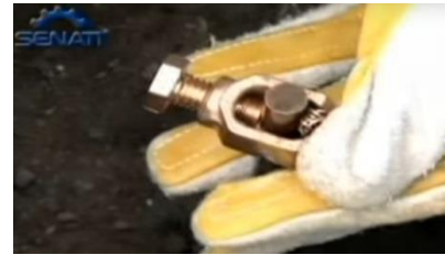
Imagen 108. Conexión del electrodo y su respectivo conductor.
