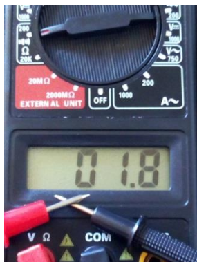
Imagen 120. Prueba de funcionamiento (Continuidad).
