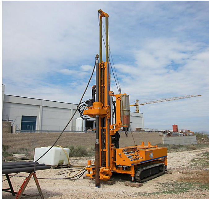
Figura 12 Perforación con penetrómetro estándar
