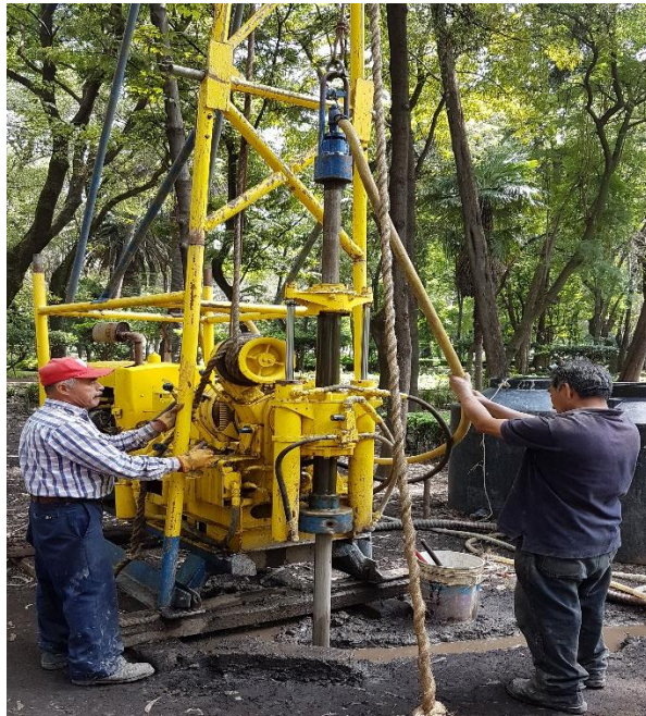
Figura 13 Perforación con tubo Shelby
