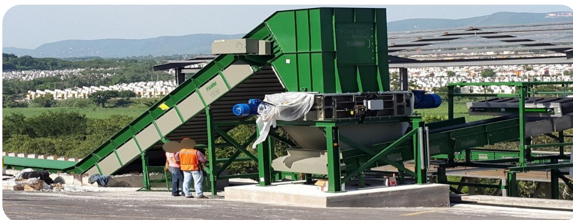
Planta de Xochitepec antes de su construcción, utilizada para depositar basura a cielo abierto.
