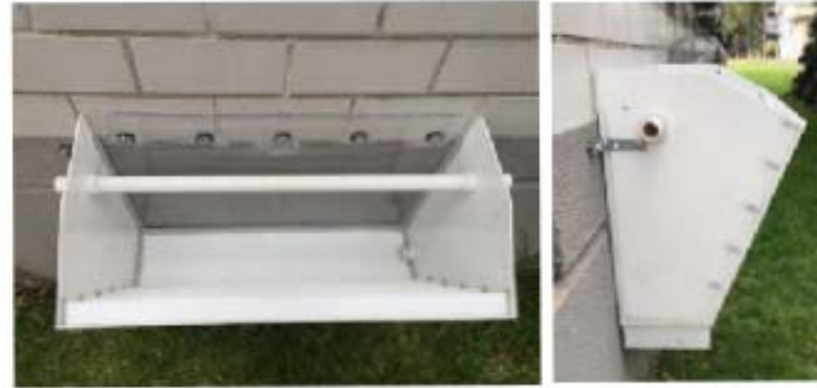
Figura 11. Módulo fijado a muro a base de taquetes y escuadras unión Fuente: Elaboración propia
