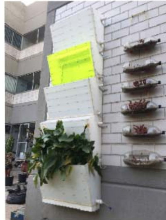
Figura 22. Fijación de módulos en muro Fuente: Elaboración propia
