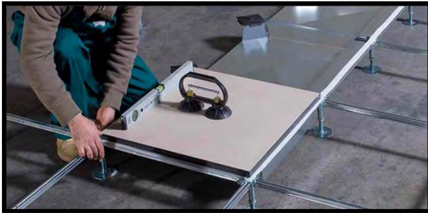
Figura 4 Instalación de piso falso
