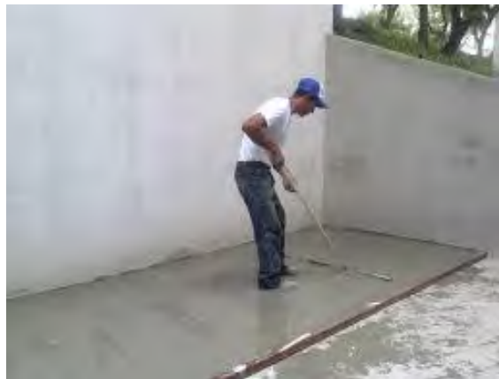
Ilustración 15 Capas de nivelación en pisos y losas.
