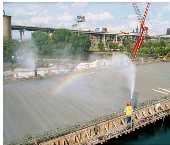
Ilustración 13 Curado de Concreto ligero estructural.
