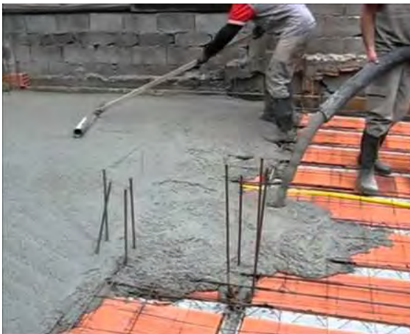
Ilustración 12 Colocación de concreto ligero estructural bombeado.
