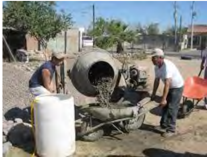
Ilustración 9 Mezclado de Concreto.
