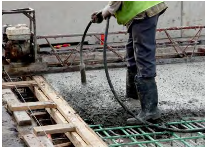
Ilustración 11 Método de vibrado para compactación de concreto en una losa.
