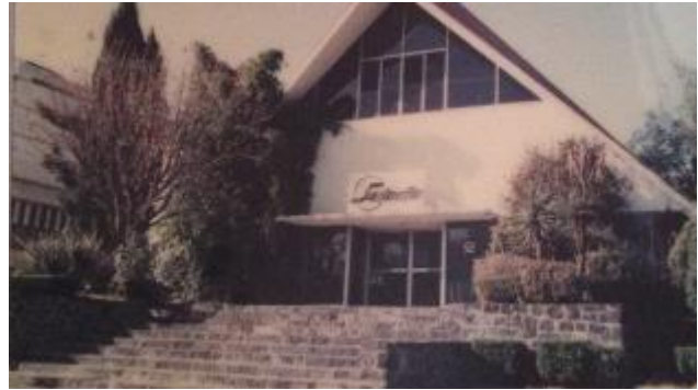
Imagen 27 Fachada de las instalaciones del sindicato (1985-2004)
