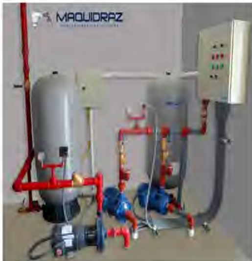
Componentes de un sistema Hidroneumatico
