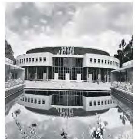
Fachada principal del auditorio
