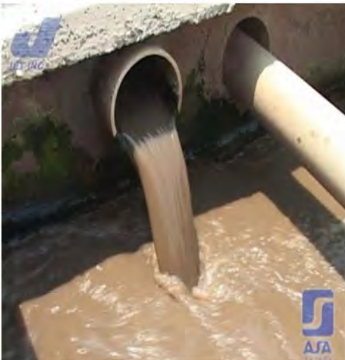
2 - Regulación y bombeo
