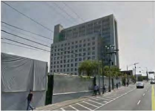
Vista a edificio CONAGUA, desde avenida Insurgentes. ●
