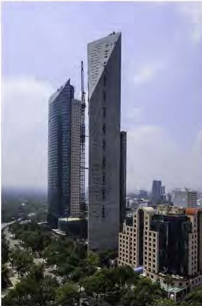
Vista torre Reforma, en proceso de obra.
