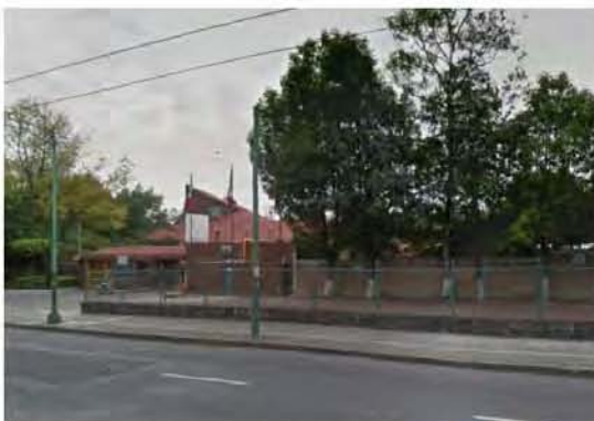
Vista a Club Terranova, Avenida Copilco. ●
