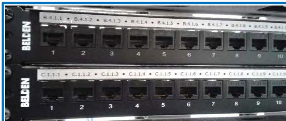
Fig. E 4.1. Etiquetado en paneles de parcheo.
