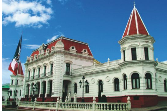
Palacio Municipal. Fuente: Google (Sep.2016)
