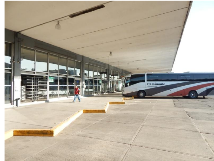
Andenes de Abordaje, Terminal Central de autobuses del Poniente. Fuente: Propia (2015)
