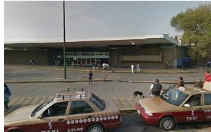
Acceso, Terminal Central de Autobuses del Poniente. Fuente: http://www.defe.mx (2015)
