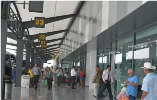
Central de autobuses monterrey delimitando andenes con cajones por medio de la estructura. Fuente: google.com
