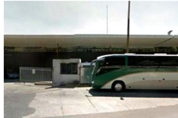
Caseta control de autobuses, Terminal central de Autobuses del Poniente. Fuente: http://mexicoautobuses.com (2015)
