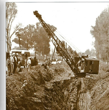
Trabajos de entubamiento del canal 1936
