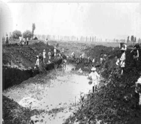
Desviación del Canal para hacer la avenida.
