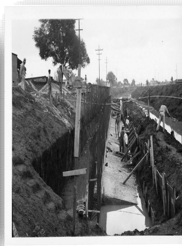
Entubamiento del Canal.
