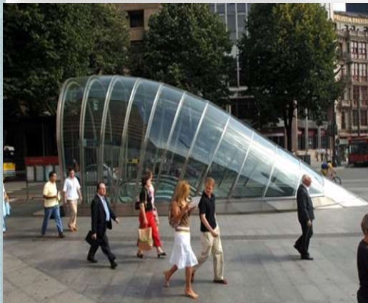
4.- ACCESO AL METRO
