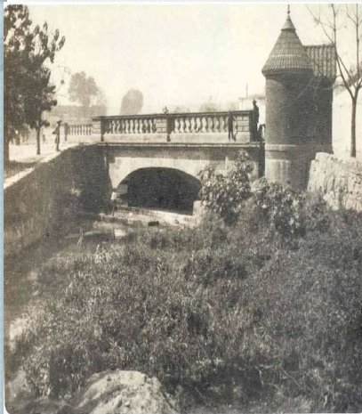
1.- PUENTE DE LA VIGA
