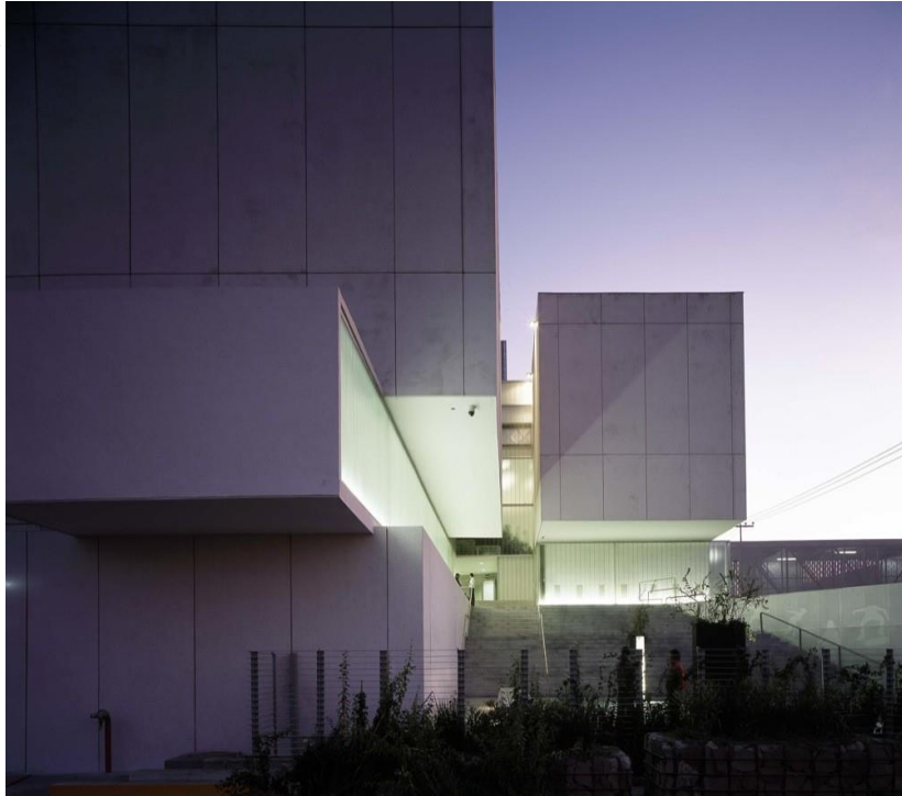
Vista de acceso peatonal de Mexipuerto
