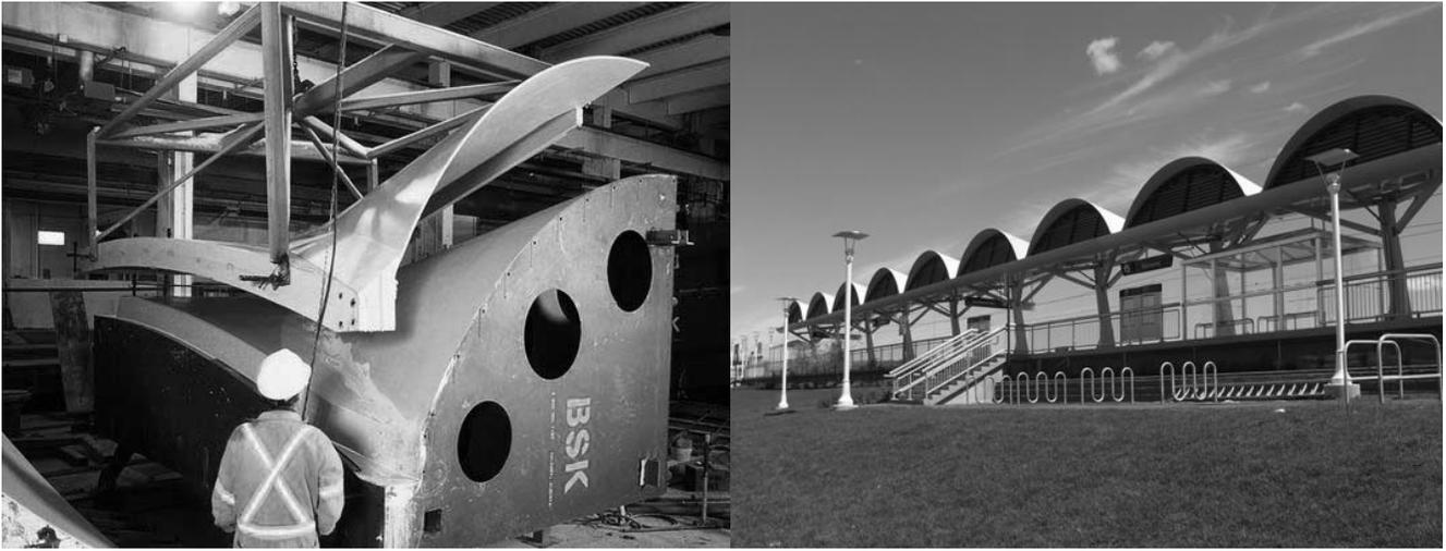
Img. 44. A la izquierda, desencofrado de una de los 24 cascarones de concreto que forman la cubierta de la estación de trenes de Shawnessy.
