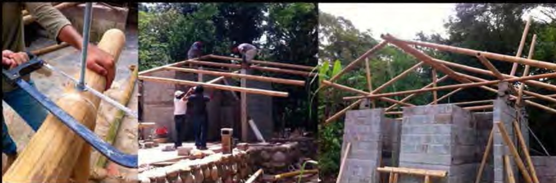
Las fotografías en obra fueron obtenidas por algún miembro del equipo en las diversas etapas de construcción.
