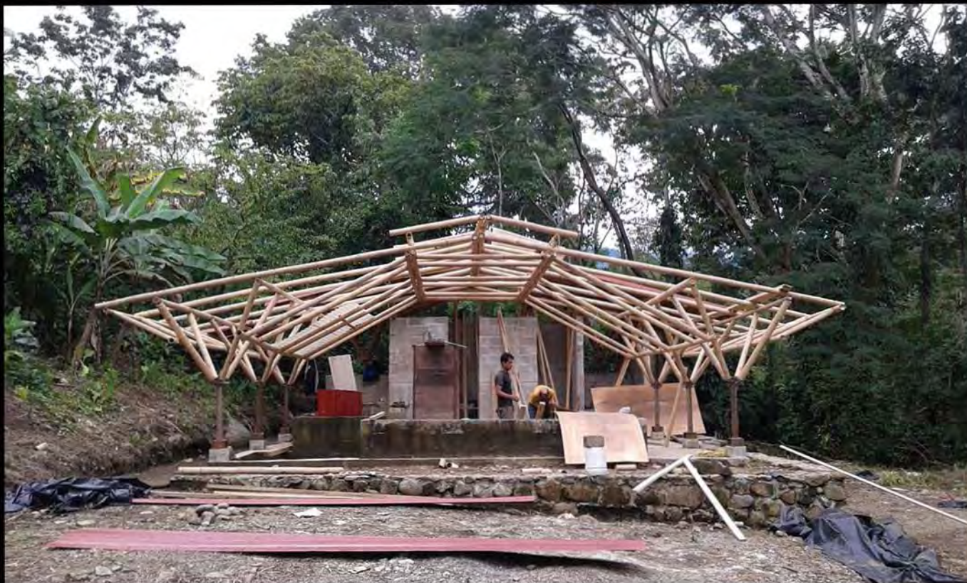
Vivienda Transitoria para migrantes, Vista de la vivienda oeste en el transcurso de la construcción de la estructura de bambú. Fuente: Propia 2015
