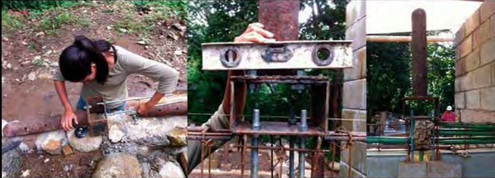
Las fotografías en obra fueron obtenidas por algún miembro del equipo en las diversas etapas de construcción.
