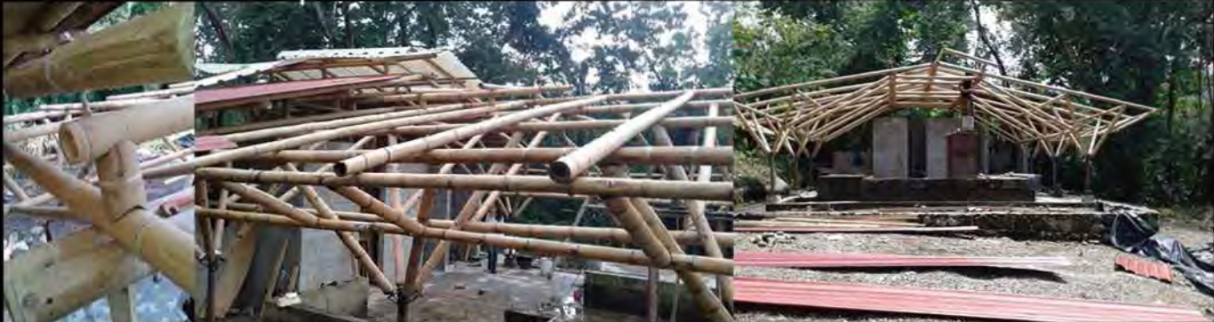
Las fotografías en obra fueron obtenidas por algún miembro del equipo en las diversas etapas de construcción.
