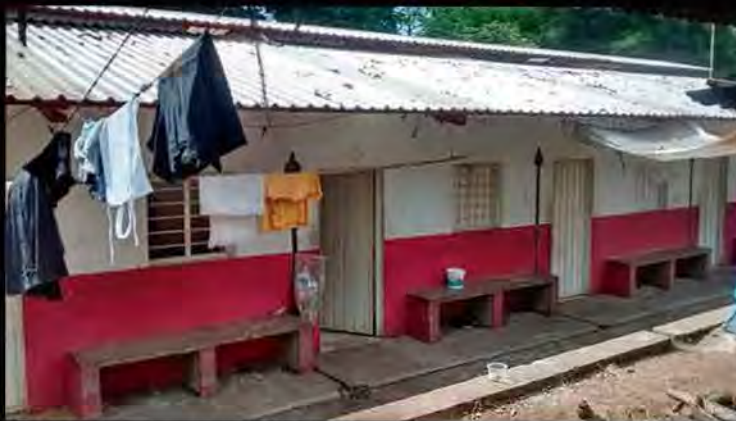
Fachada de gallería construida por SEDESOL. Fuente: Leticia Dávila. 2016.
