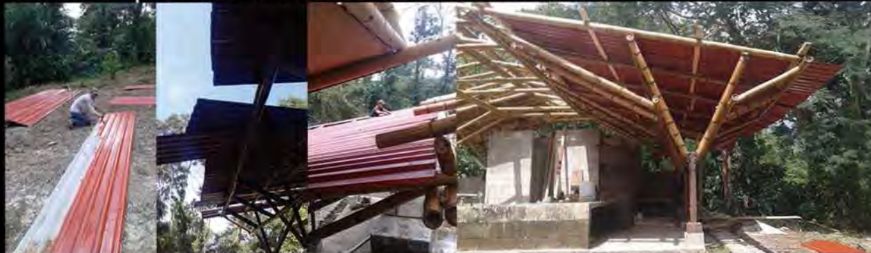
Las fotografías en obra fueron obtenidas por algún miembro del equipo en las diversas etapas de construcción.
