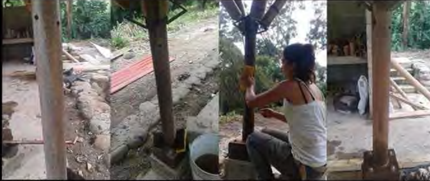
Las fotografías en obra fueron obtenidas por algún miembro del equipo en las diversas etapas de construcción.
