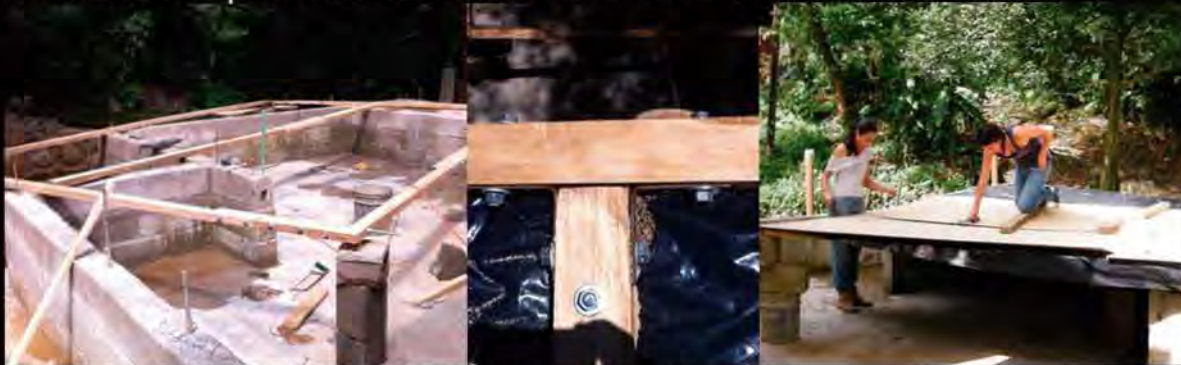
Las fotografías en obra fueron obtenidas por algún miembro del equipo en las diversas etapas de construcción.
