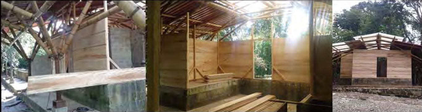
Las fotografías en obra fueron obtenidas por algún miembro del equipo en las diversas etapas de construcción.
