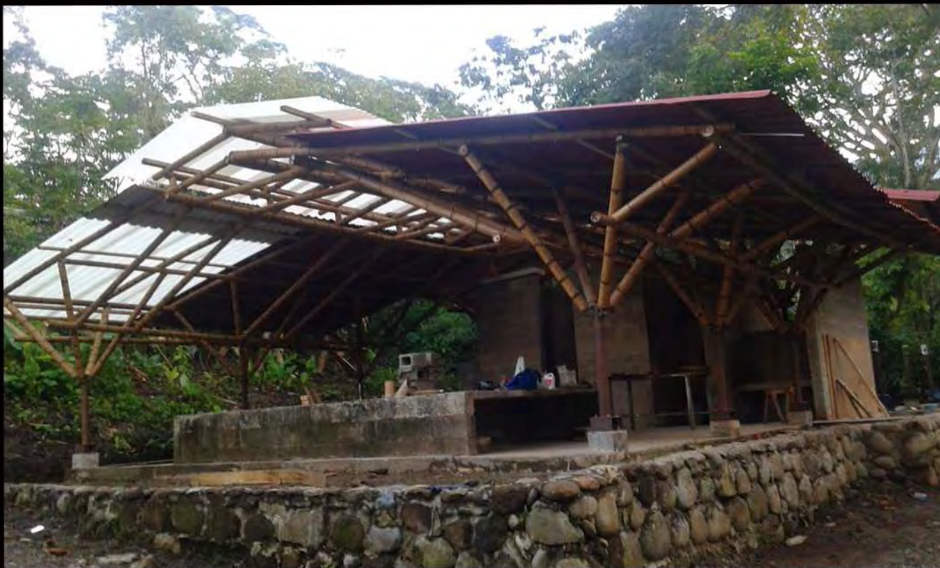
Vivienda Transitoria para migrantes, Vista de la vivienda oeste una vez finalizada la etapa de bambú. Fuente: Propia 2015
