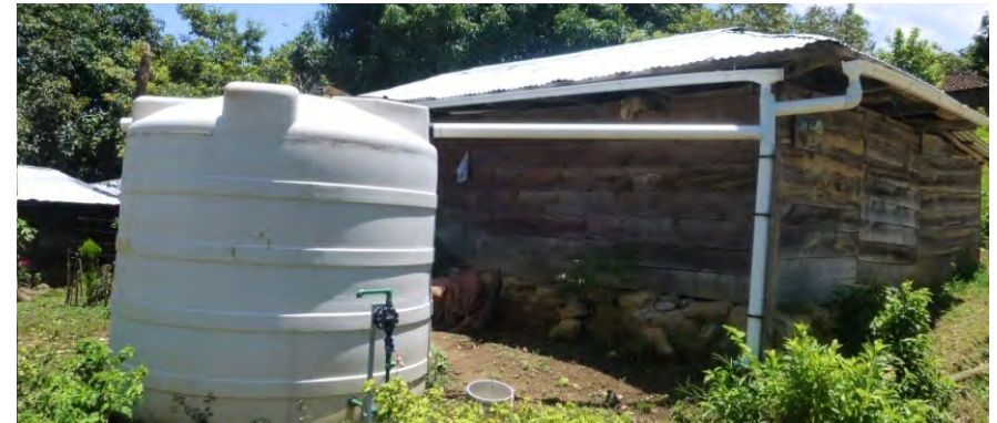
Ilustración 13. Implementación de sistema de captación pluvial.
