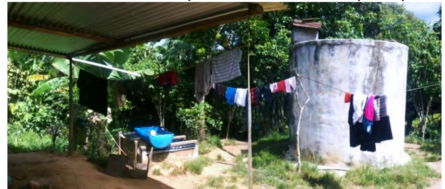
Ilustración 14. Tanque de ferro-cemento hecho en sitio.
