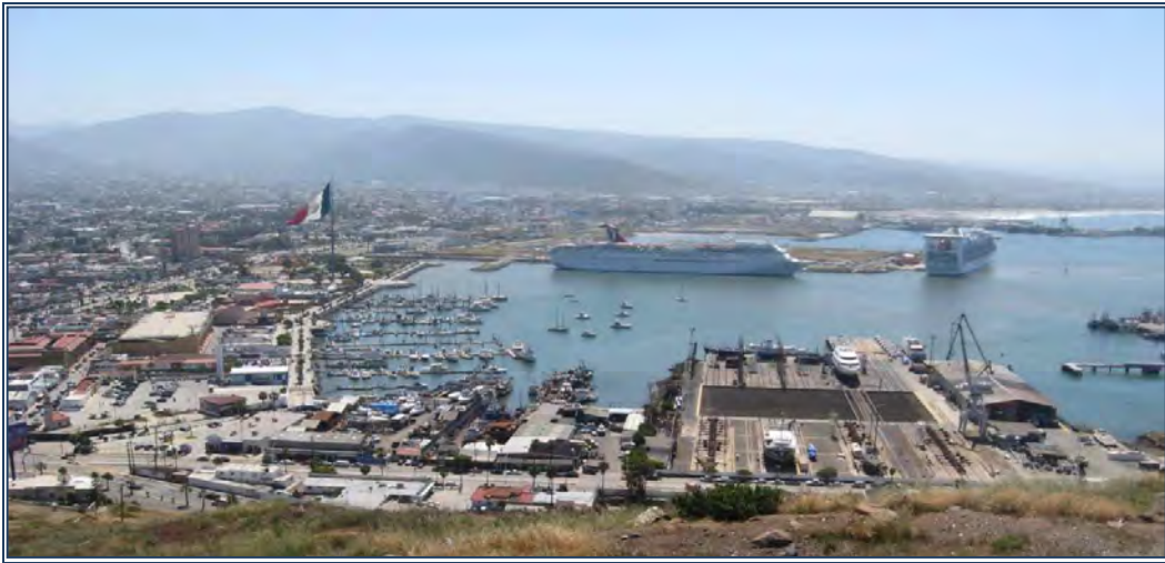
Imagen 2.1. Infraestructura del puerto de Ensenada.
