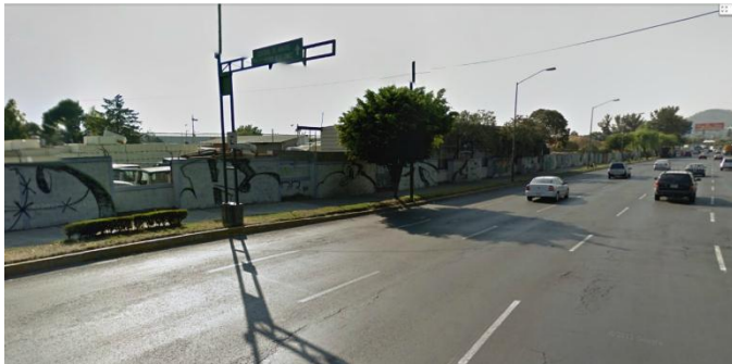
Foto 4 "Barda perimetral Eje 6"
