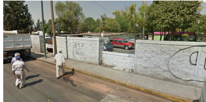
Foto 7 "barda perimetral posterior "
