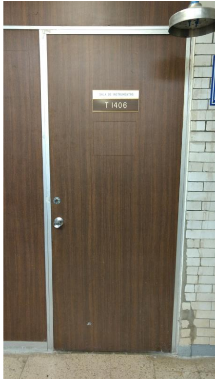
Figura 9. Acceso a la sala de instrumentos.
